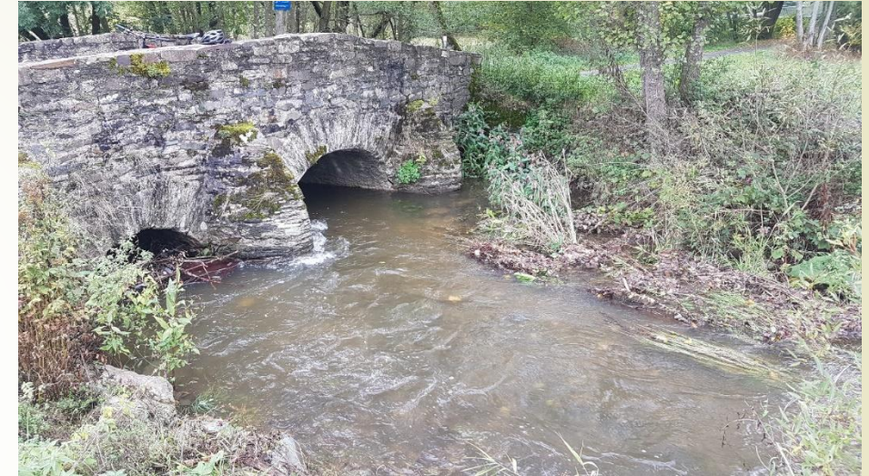
Brücke unterhalb des Gertrudenhammers mit Normalwasserstand und Trockenfall, Bild Herbert Wischmann
