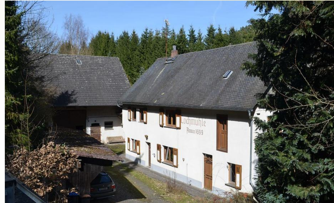
Bild: Lochmühle von der Straße aus Kulturdenkmäler in Hessen
